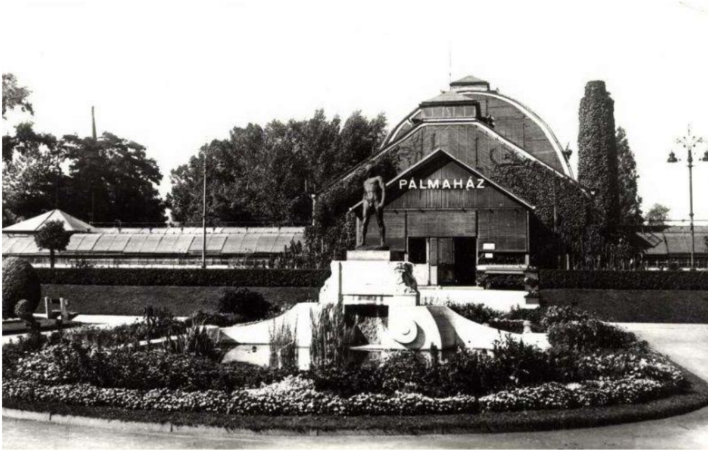
Figura38 . Invernadero de palmeras de Budapest con calefacción geotérmica [17]
