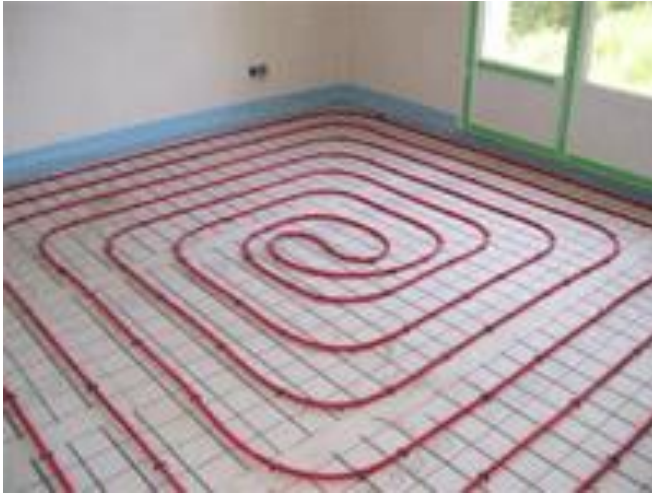
Figura 34 Ejemplo de suelo radiante
