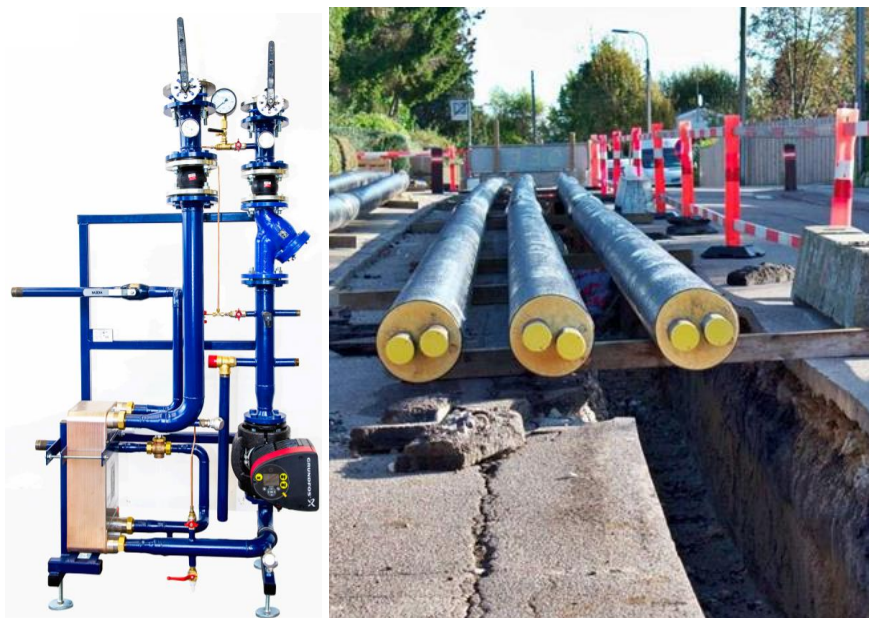
Figura8 . Subestación modular prefabricada de calefacción urbana (izquierda) (fotavhu) , tuberías preaisladas (derecha) (magyarepitok)
